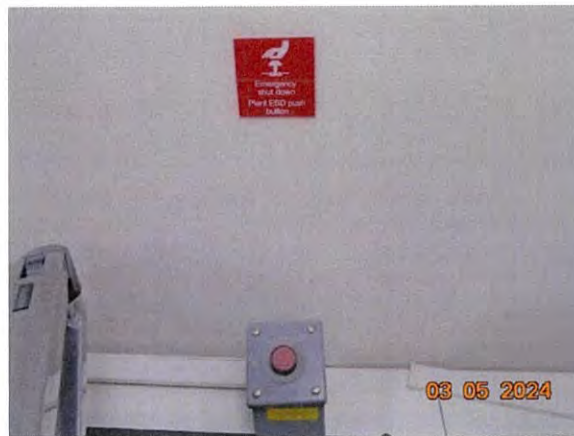
ภาพที่ 2.2-56 ปุ่ม Emergency shutdown
