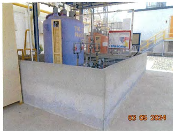
ภาพที่ 2.2-52 คันคอนกรีตล้อมรอบที่เก็บสารเคมี
