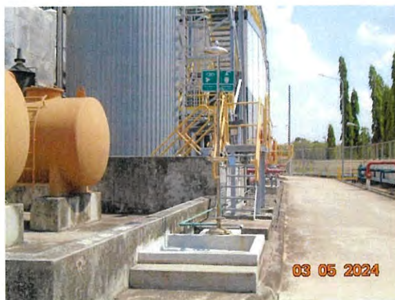
ภาพที่ 2.2-50 อ่างล้างตาฉุกเฉินและ ฝักบัวฉุกเฉิน
