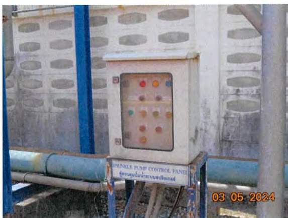
ภาพที่ 2.2-26 ตู้ควบคุมปั๊มน้ำทิ้งกลับมาใช้น้ำต้นไม้
